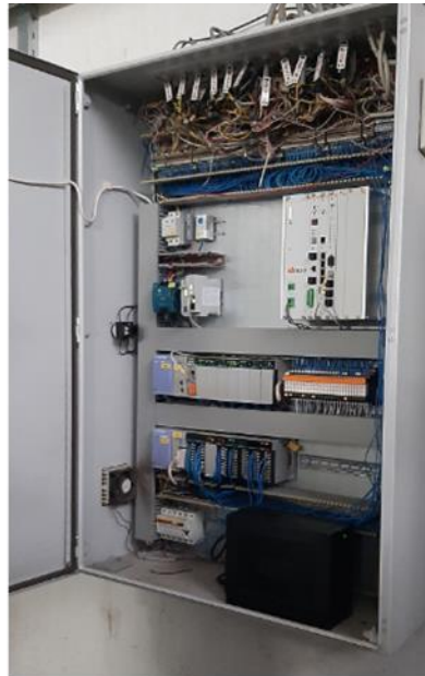
Razvodni ormar u toplani
